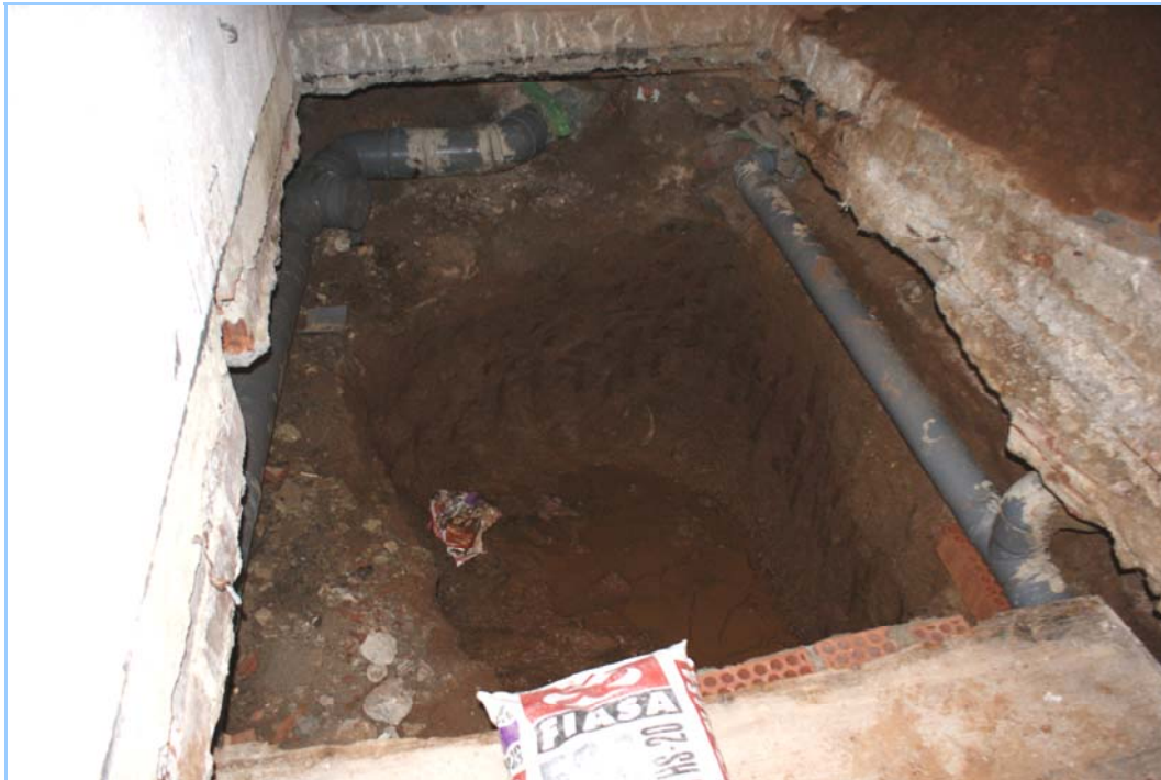
1) Fotografia de l'estat del fossat de l'ascensor en els inicis dels treballs de control arqueològic.
